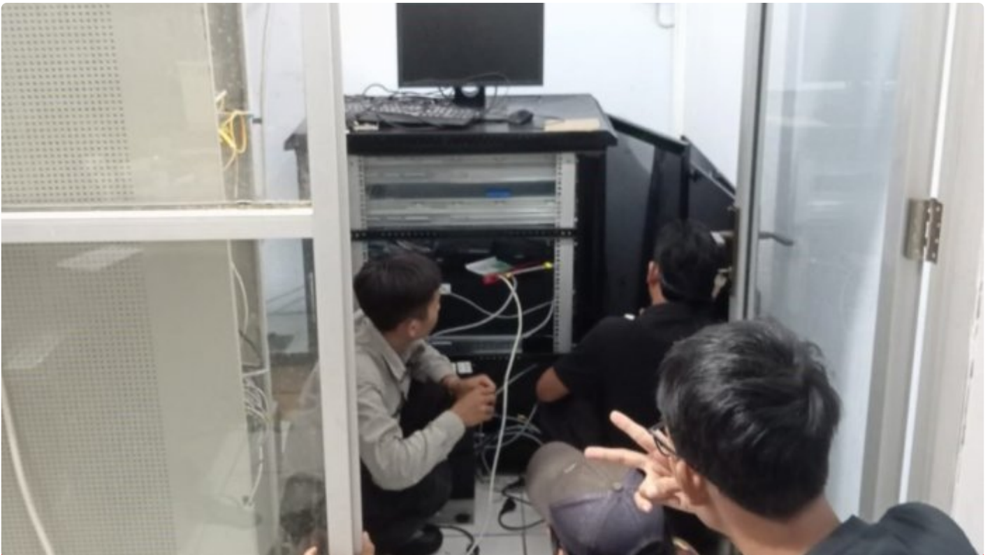
Tingkatkan Pengamanan, Lapas Besi Lakukan Perawatan Server CCTV
