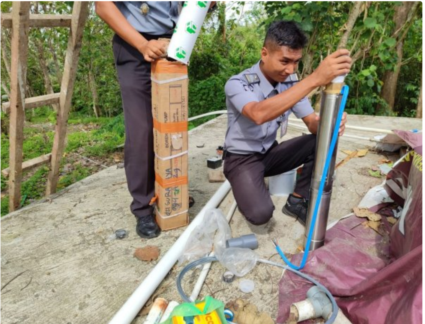
Penuhi Suplai Air Bersih, Lapas Besi Pasang Pompa Submersible
